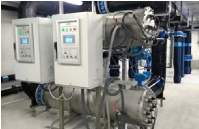
УФ-установки производительностью 600 куб. м в час на линии подпитки пресной водой (Норвегия)
