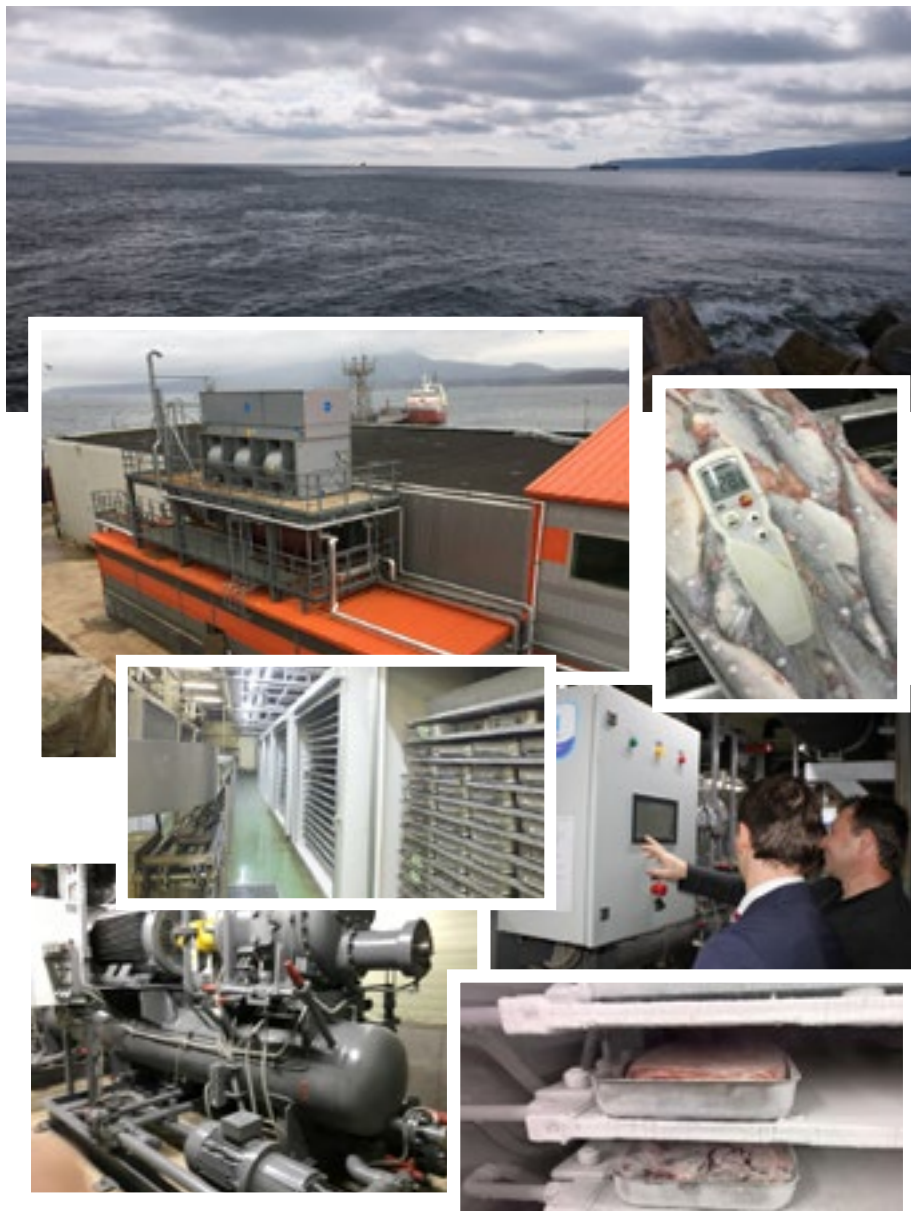
Остров Кунашир, Южно-Курильский рыбокомбинат. Проектирование, поставка и монтаж системы холодоснабжения на базе компрессоров HOWDEN Аммиачная системы ХС. Суммарная мощность системы заморозки 200 тонн/сутки и аммиачный холодильник на 1500 тонн
