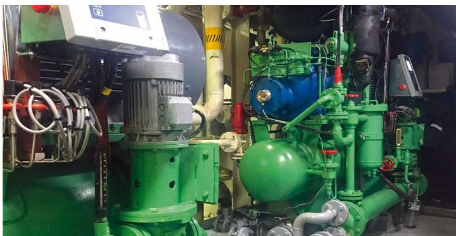
Модернизированный компрессорный агрегат. В итоге цикл заморозки уменьшился с 2 часов 30 минут до 1 час 45 минут
