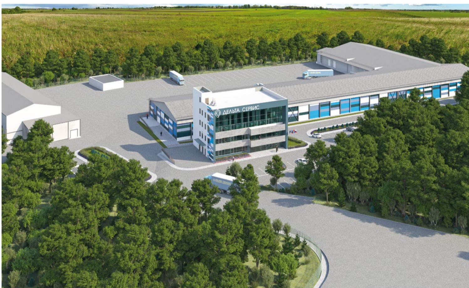
Мультитемпературный холодильный комплекс вместимостью до 8 000 тонн начнет работу в Приморье в начале 2022 г.
