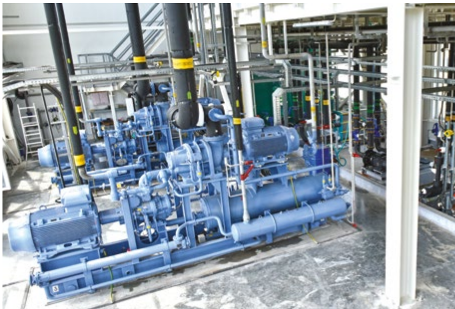
Зеленые технологии от GEA: аммиачная система холодоснабжения для рыбоперерабатывающего комплекса «Русский минтай» (РРПК)
