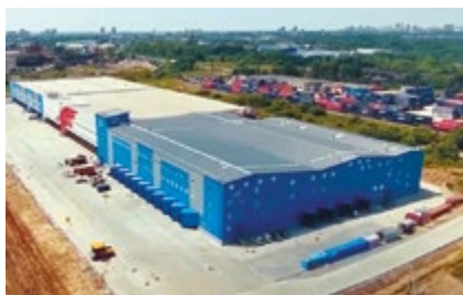
Промышленный холодильник на 25 тыс. тонн, спроектированный и смонтированный специалистами компании «Колд Трейд» в 2020 г. Объект расположен на территории индустриального парка «Авангард» в составе ТЕР «Хабаровск»
