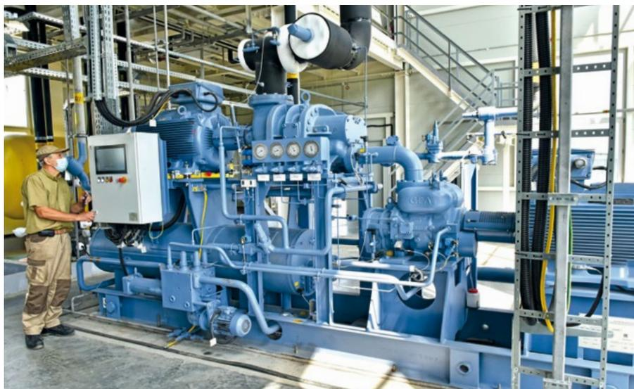
Винтовой двухступенчатый компрессорный агрегат GEA в работе
