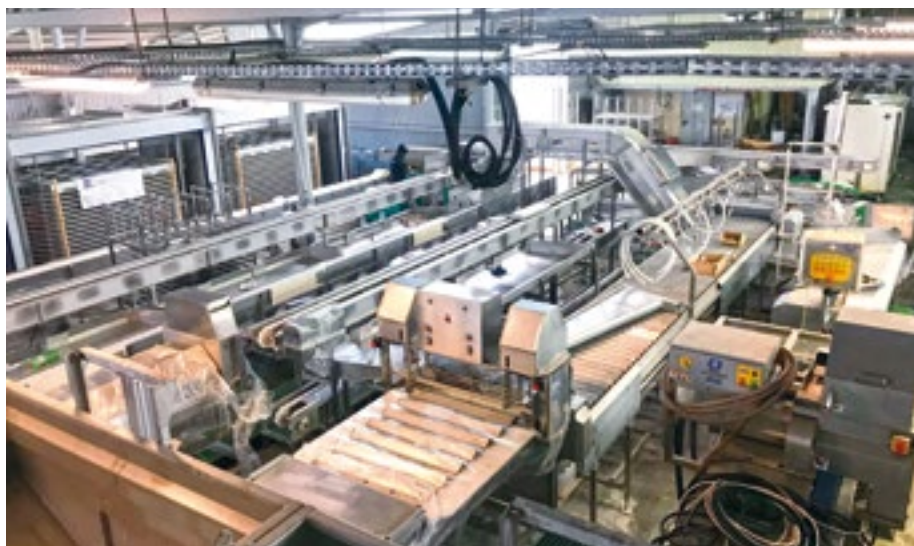
Переоборудованный рыбоперерабатывающий завод компании «Хангар»
