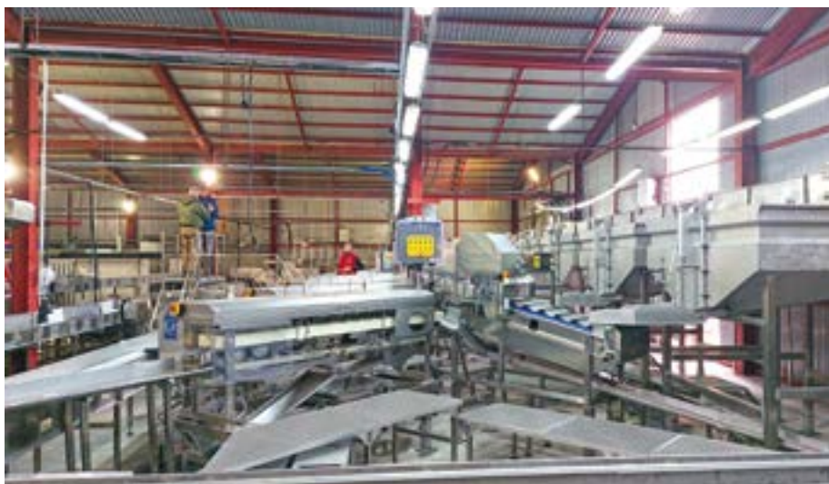
Монтаж оборудования на заводе «Западный берег»
