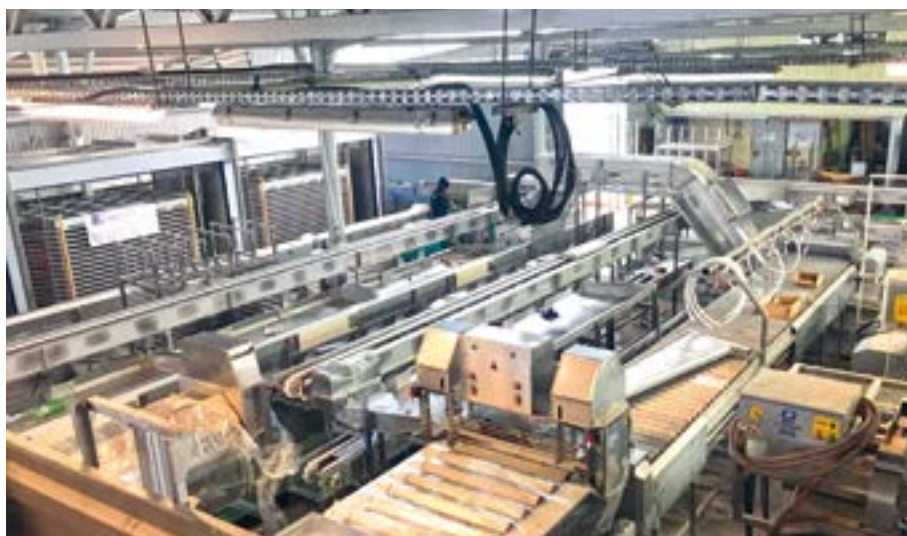
В помещении старого производства ООО «Хангар» при относительно небольших вложениях удалось создать новый завод мощностью вдвое больше прежнего
