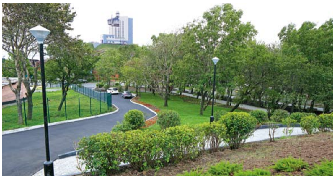
В сквере проведена планировка территории и земляные работы, благоустроены пешеходные дорожки и клумбы, смонтированы лестницы, установлены фонари, обустроены откосы
